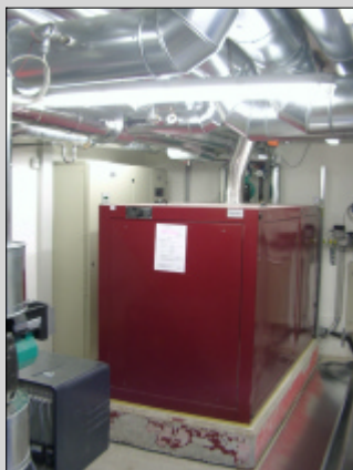
Blockheizkraftwerk
